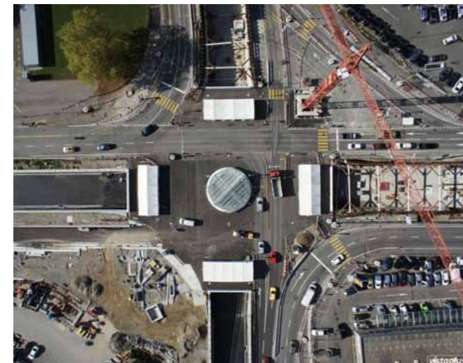
Adlerauge auf der Baustelle: Die Aufnahmen des Wankdorf-Kreisels im Bau wurden von einer «Asctec»-Drohne gemacht.
